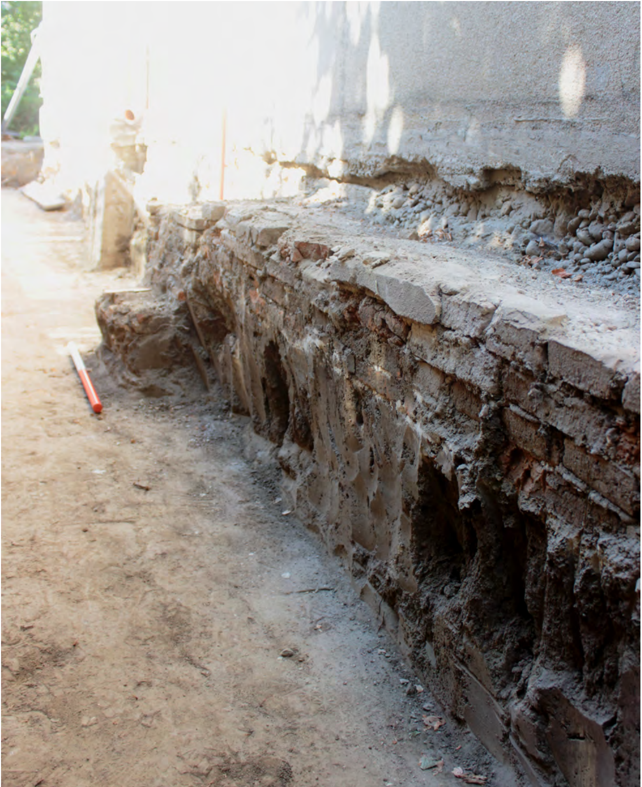
Fig. 44. Vechea fundație a Casei Cuza-Vodă, descoperită în 2020 (Arhiva științifică a Muzeul de Istorie „Paul Păltănea” Galați).
